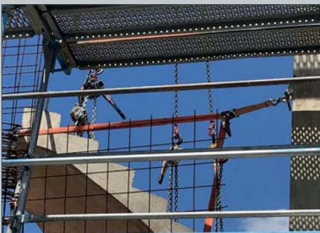
Positionierungsarbeiten bei dynamischen Lasten insbesondere bei Verwendung mehrsträngiger Kettengehänge (z. B. Einbau von Turbinen)
